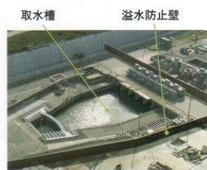
溢水防止壁の設置イメージ
